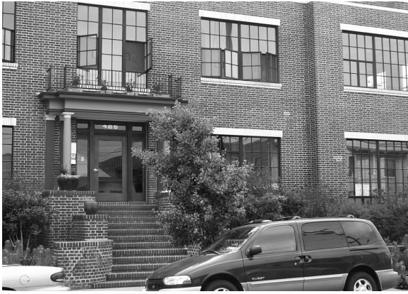
Các tòa nhà nhiều tầng cũng có thể hội đủ điều kiện tham gia chương trình.
