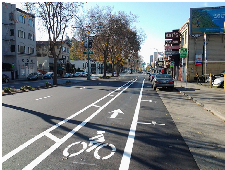
Broadway (38th St 到 Broadway Ter) 上新劃設的標線，自行車道兩側都設有緩衝帶。
